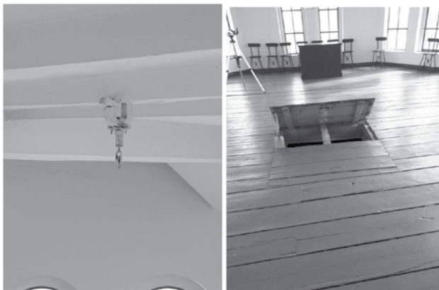
Εικόνα 2. Αριστερά: Το σημείο ανάρτησης του εκκρεμούς στον τρούλο του αστεροσκοπείου. Δεξιά: Η καταπακτή μέσω της οποίας διερχόταν το νήμα του εκκρεμούς στον τρούλο του αστεροσκοπείου (Αμφότερες φωτογραφίες: Δ. Παπίνης).
