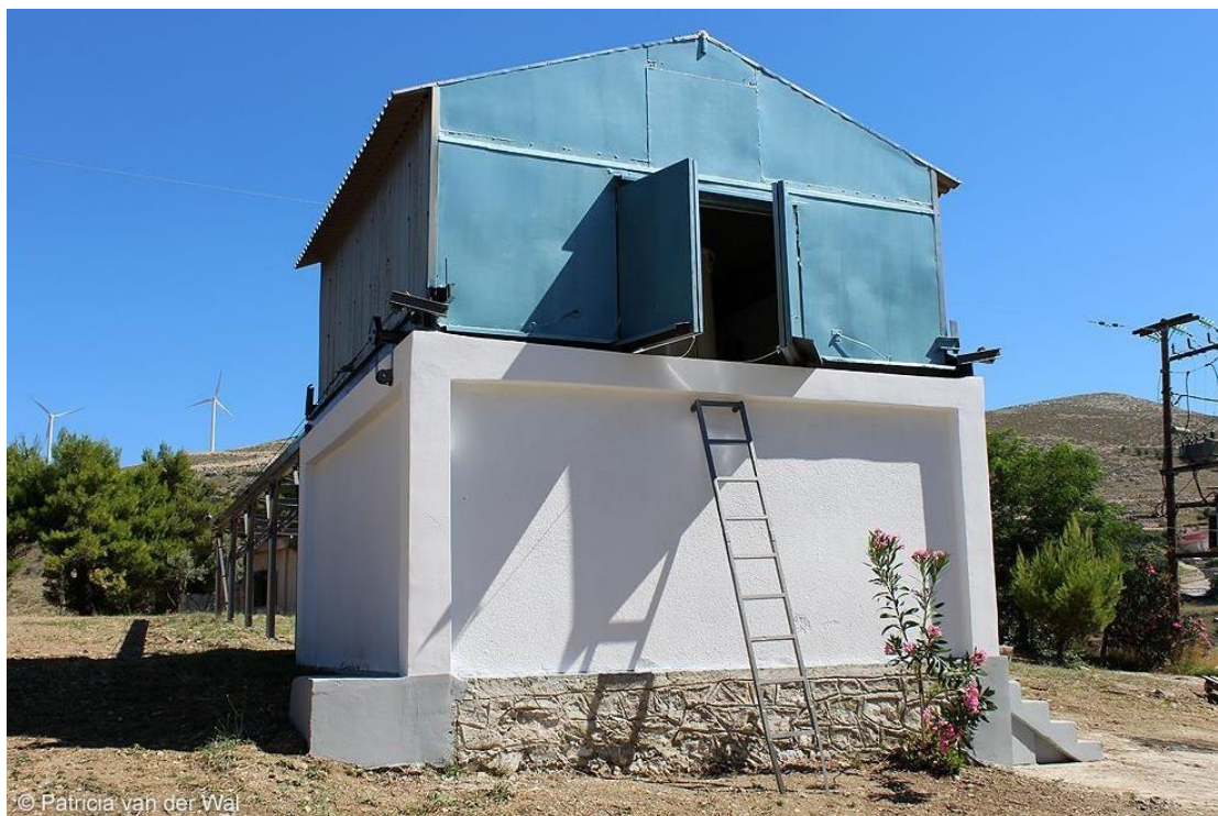
Εικόνα 12. Ο οικίσκος του τηλεσκοπίου των 30 ιντσών το 2017 μετά την ανακαίνιση
