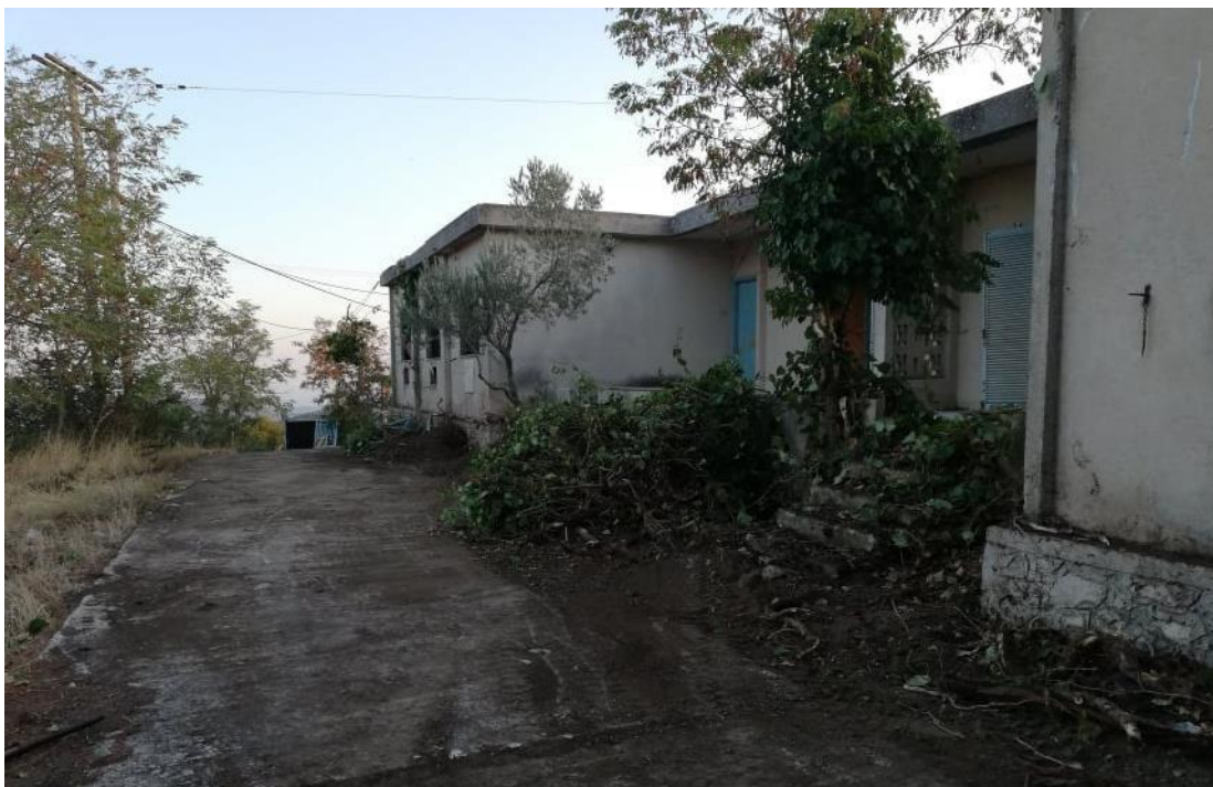
Εικόνα 11. Το κεντρικό κτήριο πριν από τα έργα αποκατάστασης (Λήψη Αντώνη Παπαντωνίου)
