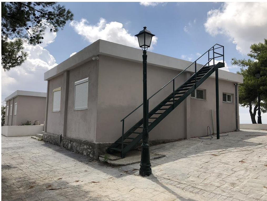
Εικόνα 21. Το κεντρικό κτήριο μετά τα έργα επισκευής και συντήρησης το 2022 (Λήψη Patricia van der Wal)
